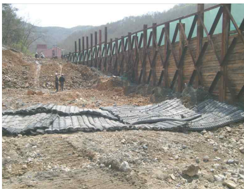
(c) 비산방지용 방호매트 설치전경
